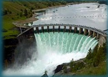
IZGRADNJA BRANA I PREGRADA
